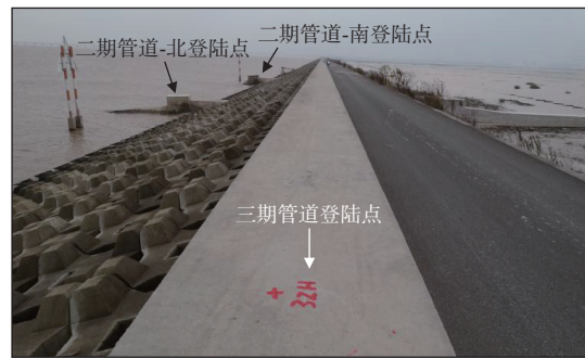
图 4 管道登陆点实拍
